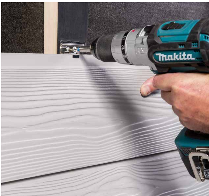
Einfache Montage der Paneele mit Klammer und Schraube auf Holzunterkonstruktion
